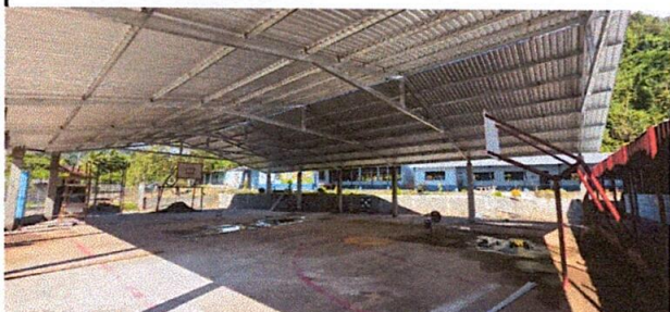
Foto 1: Cubierta de lámina finalizada.
